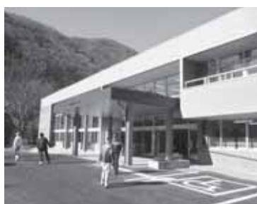
12月 耐震改修が終了した村民センター
