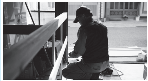
江戸枝屋と新大坂屋の壊れた玄関扉の修繕を手掛ける手塚建築の手塚和喜さん。
