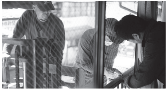
5月15日（水）屋号看板設置のためのL字型の鉄骨を木祖産業協同組合の職人方が取り付けました。
