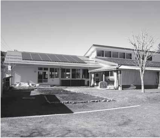
平成24年にとちのみ保育園の屋根に設置された太陽光パネル
