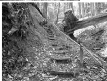
水木沢天然林の遊歩道修繕箇所
