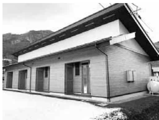
菟原三角土場に建設された一里塚集合住宅
