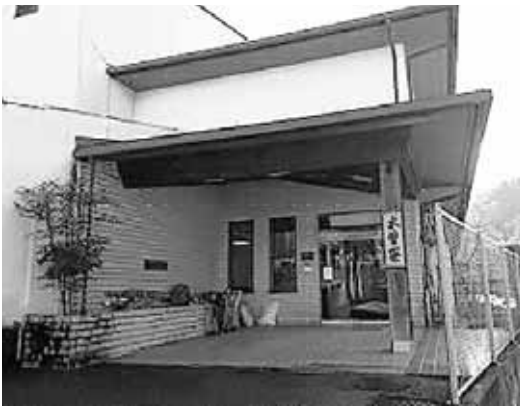
老朽化により改修が予定されている木曽寮
