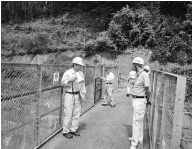
●塩沢峠橋修繕
