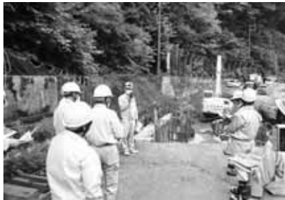
国道数原改良橋梁下部工工事
