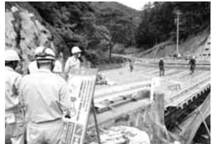
菅川橋修繕工事
