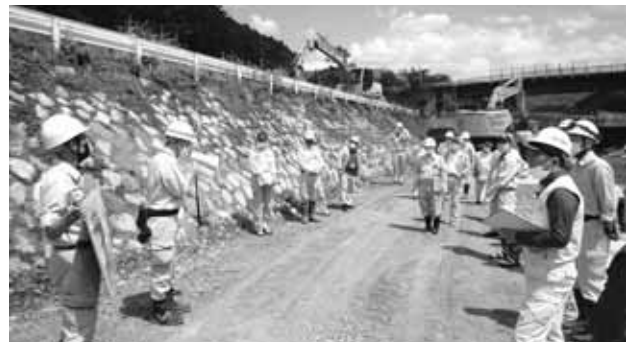
令和3年度 3災公共土木施設災害復旧工事（寺平橋上）
