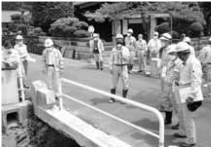
神出橋災害対策工事
