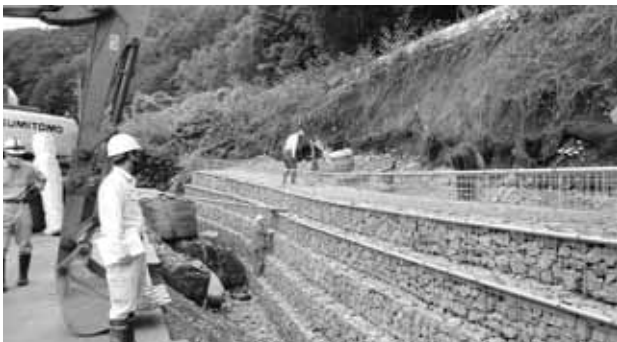
奥峰沢川災害復旧工事（スキー学校前）
