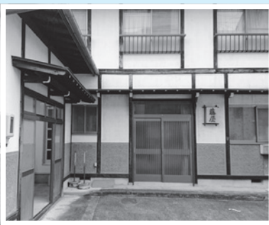
②藤屋（藪原6区）
