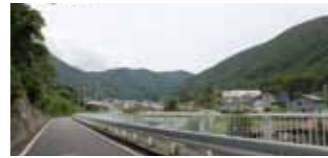
木曽川沿いの道 木祖村らしさを演出できる沿道構造物とすることで、木祖村を俯瞰的に眺められる沿道景観を創出します
