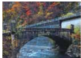
土木遺産の認定を受けた旧菅橋
