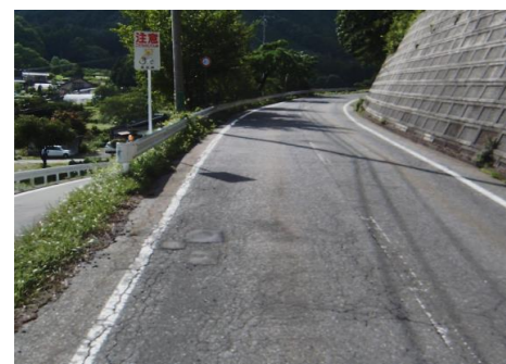
＜破損が目立つ道路舗装＞
