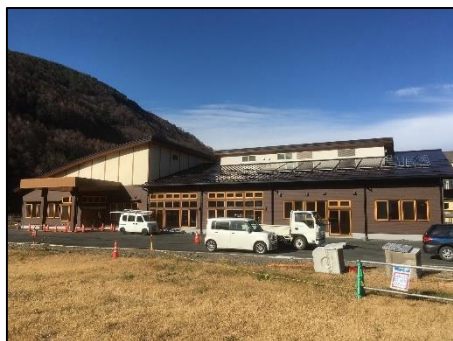
幸せテラスまめのわ 太陽光発電パネル
