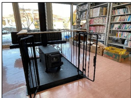
木祖村民センター 薪ストーブ
