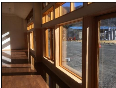
幸せテラスまめのわ 木製の窓枠
