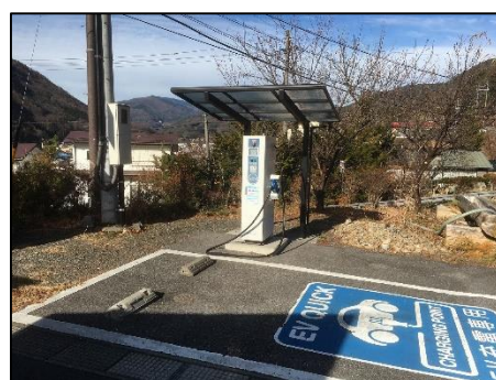
道の駅 電気自動車充電器の設置
