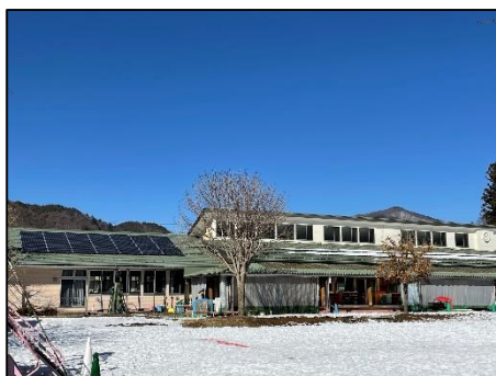
とちのみ保育園 太陽光発電パネル
